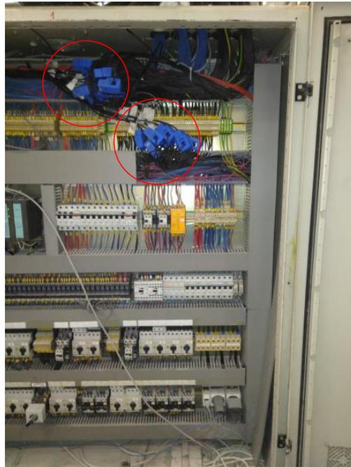
*Imagen: Sensores de corriente para medir consumo motores muelas.*
