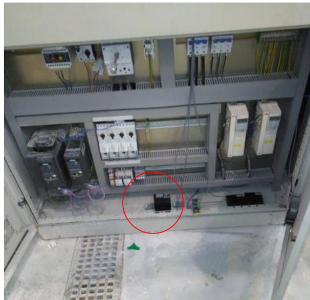
*Imagen: Transformador para medir consumo general de la máquina*
